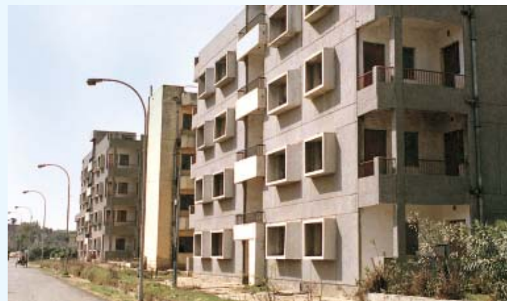
MIG Flats at Narela
